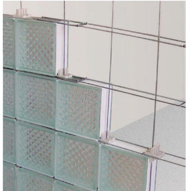
**Es fundamental el uso de separadores plásticos VISEPRAC para una correcta y rápida colocación del vidrioblock.**
